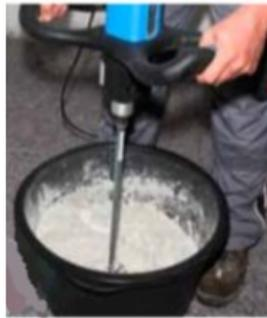
Pro Sack Hydrosilikatkleber SK ca. 7 Liter Wasser zugeben und mit einem langsam laufenden Rührwerk zu einer homogenen, klumpenfreien Masse anrühren.
