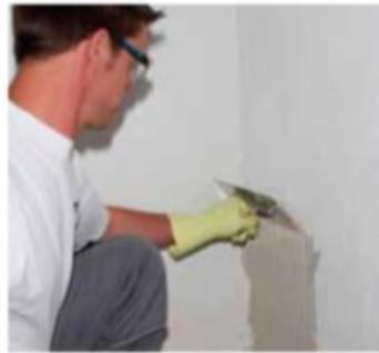
Der Hydrosilikatkleber SK ist anschließend mit einem Zahnpachtel (mind. 8 mm Zahnung) Schritt für Schritt vollflächig auf den Untergrund aufzutragen.
