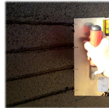
Kratzpachtelung (bei mineralischem Untergrund) aufbringen. Anschließend 2-lagige Abdichtung aus BEWAPLAST 1K (Ggf. mit Beschleuniger) bzw. BEWAFLEX 2K aufbringen. Ab Lastfall „aufstauendes Sickerwasser“ DIN18195-6 unter mittiger Einlage von BEWALAN Gittergewebe Nr. 3
